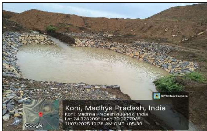
Siltation Pond Check Dams
