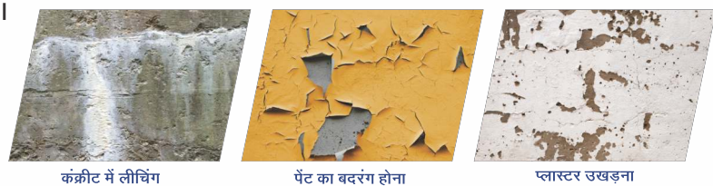
कंक्रीट में लीचिंग पेंट का बदरंग होना प्लास्टर उखड़ना
