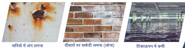
सरियों में जंग लगना दीवारों पर सफेदी जमना (लोना) टिकाऊपन में कमी
